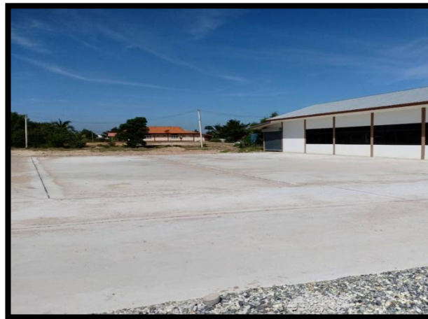
ลานคอนกรีต
